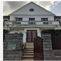
Praha 4 Doudova 258/3 sídlo u advokátní kanceláře
