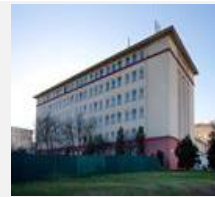
Praha 10 Počernická 272/96 velký objekt
